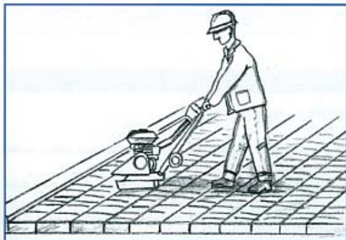
Fig. 30 - Compattazione della pavimentazione in masselli
